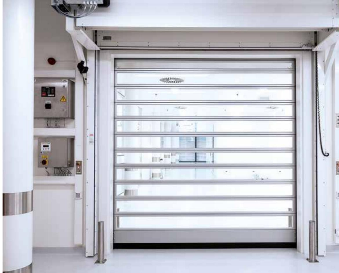
Kurzfristig realisierten unsere stets einfallreichen EFAFLEX-Konstrukteure eine passende Sonderanwendung für Lonza: **Einen Vertikalläufer**. Das Torblatt mit 40 mm EFA-THERM®-Lamellen bewegt sich nun eben vertikal. Die Zargen wurden umkonstruiert und für
